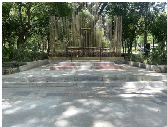
Imagen No 5 Proceso de la estructura metálica en el presbiterio
