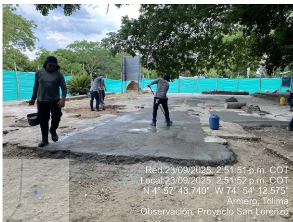
Imagen No 1. Proceso adelantado en el piso
