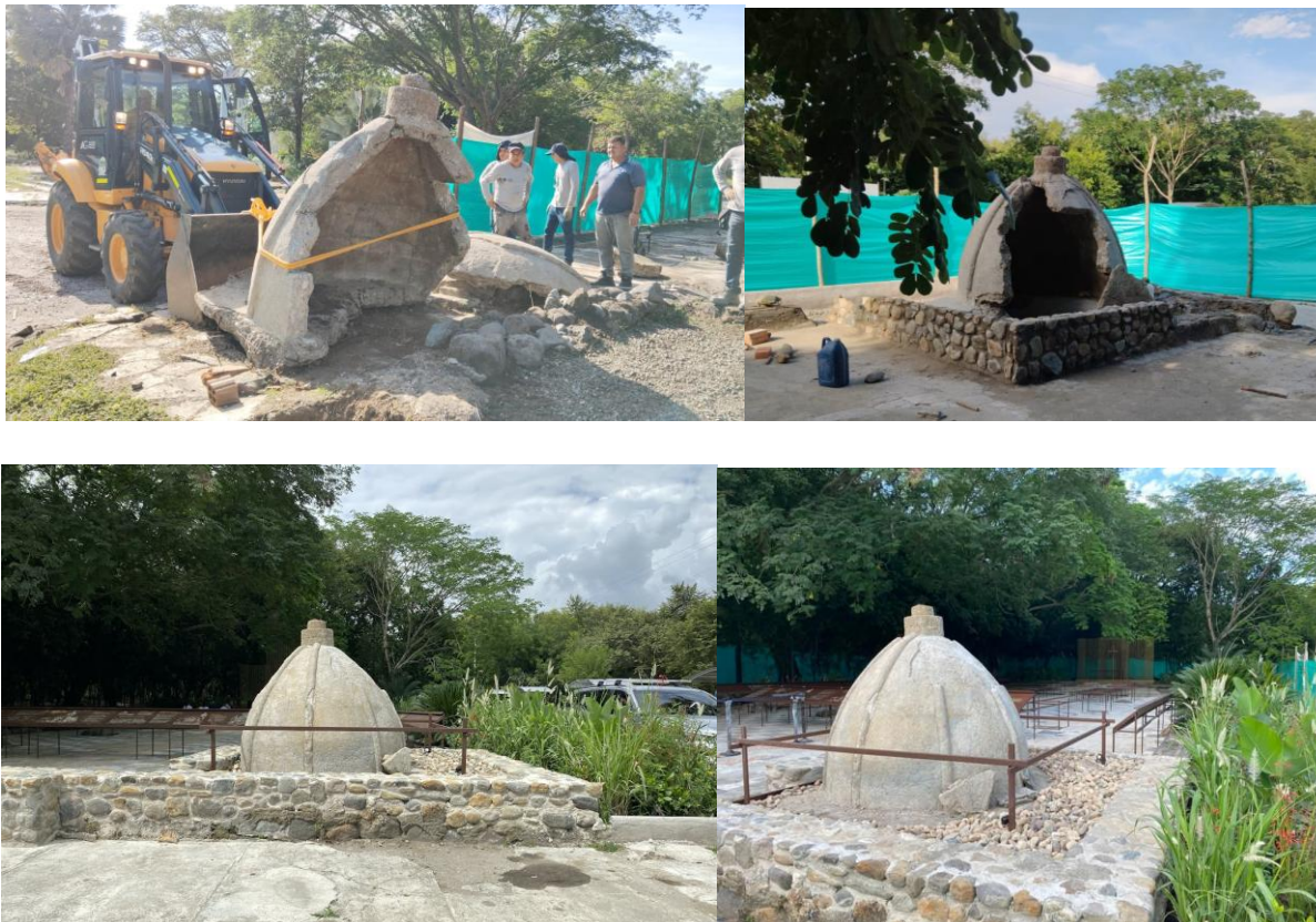
Imagen No 3. Proceso adelantado en la cúpula del campanario.
