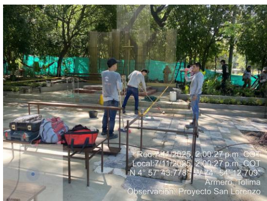
Imagen No 7 Proceso de los soportes expositivos en estructura metálica
